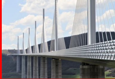
Viaduc de Millau, France - Luca Orniboni on Unsplash
