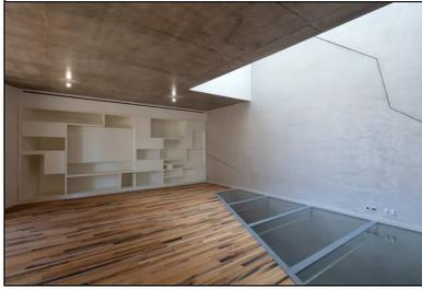
Si la structure poteaux-poutres en béton bas carbone de la maison est assez courante, un soin particulier a été apporté au coffrage des plafonds lasurés.
