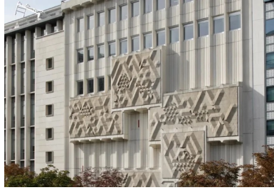
La façade sur le boulevard est animée par le calepinage des panneaux préfabriqués en béton matricé et les grands reliefs sculptés évoquant la taille-douce d'un timbre à grande échelle.
