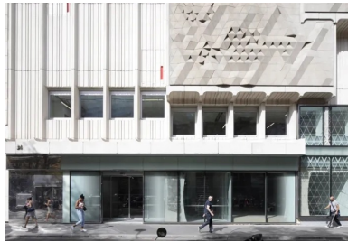
Au rez-de-chaussée, de grandes parois vitrées ouvrent l'accueil du musée, les expositions temporaires et la boutique sur le boulevard et l'espace public.
