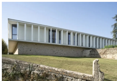
Le rythme des redents successifs est complété en façade nord-est par une série de vantelles, disposées aussi en diagonale.
