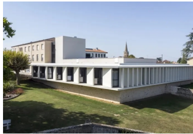
L'extension abritant l'unité Alzheimer est traitée comme un belvédère, bénéficiant d'une vue imprenable sur la vallée du Dropt.
