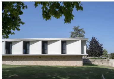
Le décalage diagonal du mur en béton blanc matricé de chaque chambre crée un jeu de redents successifs.
