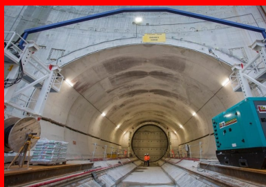
Amorces d'un tunnel réalisées depuis le puits.
