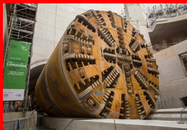
Le passage d'Amandine, tunnelier de la ligne 15, a permis de libérer le volume nécessaire à l'achèvement des neuf niveaux de planchers.
