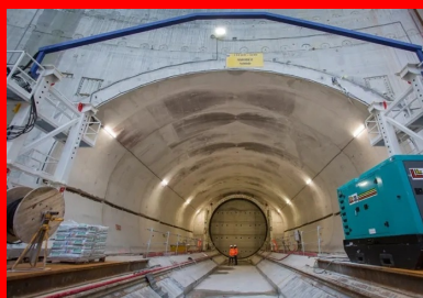
Amorces d'un tunnel réalisées depuis le puits.
