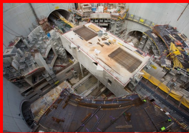
Dans un espace de travail particulièrement exigü, tous les travaux de Génie Civil se déroulaient en coactivité.
