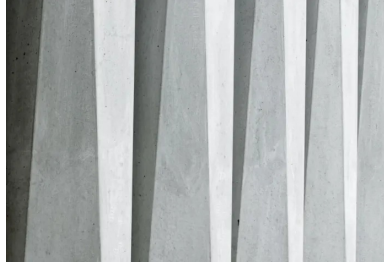
Vue de détail sur les colonnes de l'atrium.
