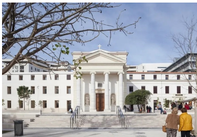
Au sud, la façade néoclassique est reconstruite avec la construction d'une aile neuve (à gauche). Elle reprend le gabarit et l'ordonnement des baies d'origine et s'inscrit en symétrie avec l'existant. ©S.Demailly
