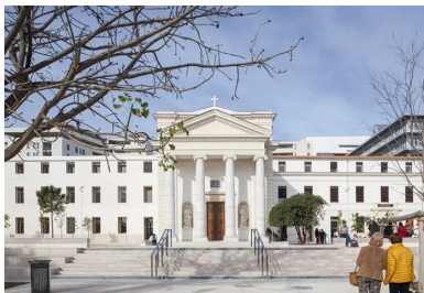
Au sud, la façade néoclassique est reconstituée avec la construction d'une aile neuve (à gauche). Elle reprend le gabarit et l'ordonnement des baies d'origine et s'inscrit en symétrie avec l'existant. ©S.Demailly
