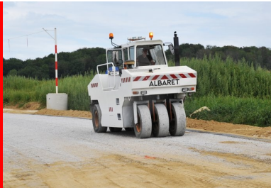
Un compacteur à roue réalise compactage final.
