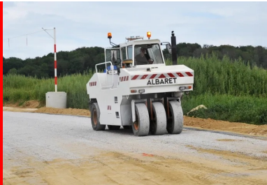
Un compacteur à roue réalise compactage final.
