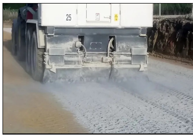
Le liant est épandu pour atteindre l'objectif d'un dosage de 5 %, avec vérification de la quantité épandue à l'essai à la bêche.
