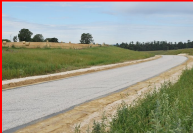
Un enduit gravillonné a été appliqué pour imperméabiliser la couche traitée et éviter la dessiccation.
