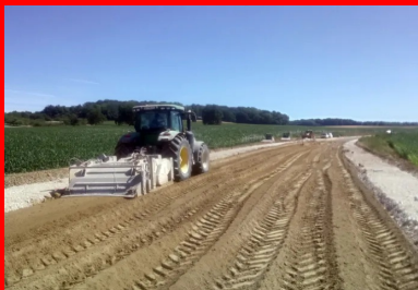
Juillet 2020. Vue générale du chantier de traitement de la couche de forme de la déviation de Ballersdorf, le plus important engagé récemment par le département du Haut-Rhin.
