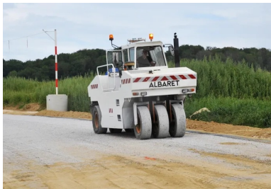
Un compacteur à roue réalise compactage final.
