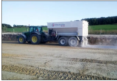
Le liant est épandu pour atteindre l'objectif d'un dosage de 5 %, avec vérification de la quantité épandue à l'essai à la bêche.
