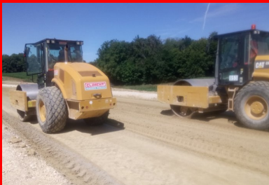
Un compactage partiel est effectué par deux compacteurs V5.
