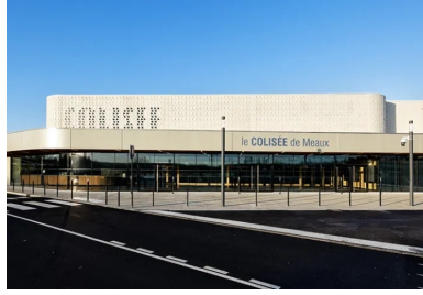
Le volume haut de la salle de spectacle émerge d'une partie à rez-de-chaussée, qui abrite le hall d'entrée. © Franck DELETANG
