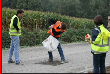
Contrôle de l'épandage à la bêche
