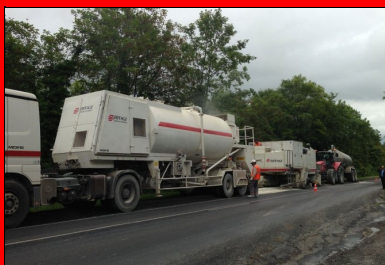
Atelier de retraitement avec épandeur de liant intégré
