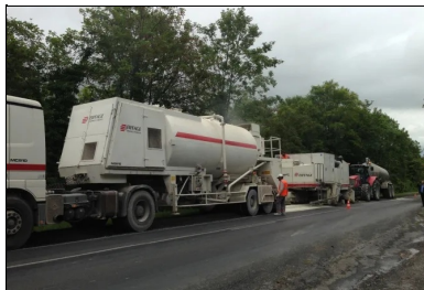
Atelier de retraitement avec épandeur de liant intégré
