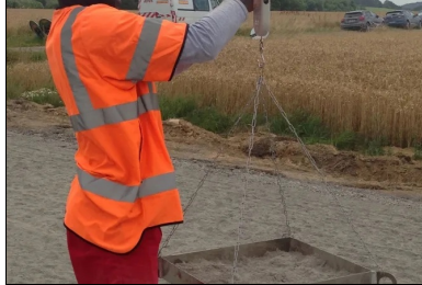
Contrôle de l'épandage au bac
