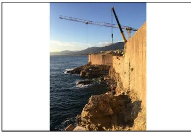
Pour porter le tablier, 23 consoles préfabriquées sont scellées dans la falaise par des tirants d'ancrage grâce à une grue et des cordistes.
