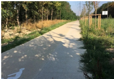
L'ouvrage a été réalisé entre deux espaces verts, à proximité immédiate de végétaux réimplantés dans une terre naturelle.
