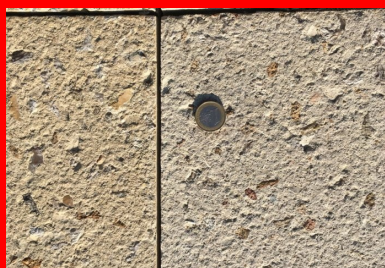
Les joints de retrait-flexion ont été réalisés le lendemain du coulage par sciage sur un tiers de l'épaisseur du béton, tous les 3 ml (piste cyclable) et tous les 1,5 ml (voie piétonne).
