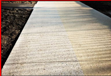
Le chantier, très linéaire a nécessité la pose de 1 800 ml de coffrage (3 x 600 ml).
