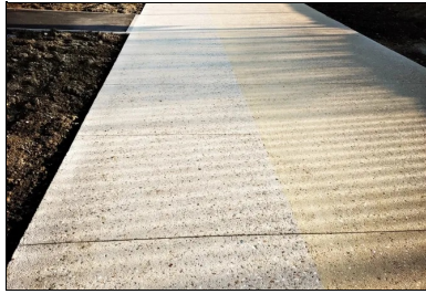
Le chantier, très linéaire a nécessité la pose de 1 800 ml de coffrage (3 x 600 mm).
