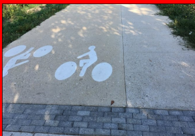
La piste cyclable et la bande piétonne ont été rapidement ouvertes à la circulation.
