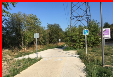
La piste cyclable réalisée début 2020 par Eurotech Floor à Aulnay-sous-Bois.
