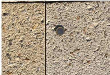
Les joints de retrait-flexion ont été réalisés le lendemain du coulage par sciage sur un tiers de l'épaisseur du béton, tous les 3 ml (piste cyclable) et tous les 1,5ml (voie piétonne).
