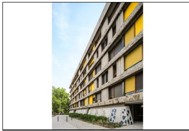
La reconstitution des angles maçonneries avec inclusion de schiste marque à nouveau chaque entrée.
