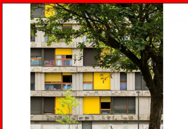
Retrouver un béton brut de qualité dans cette réhabilitation était fondamental, tant il participe à l'identité et à l'écriture architecturale de la résidence.
