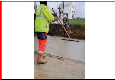
Mise en œuvre du béton à la règle vibrante par demi-chaussée pour constituer la voie avec un profil en toit.
