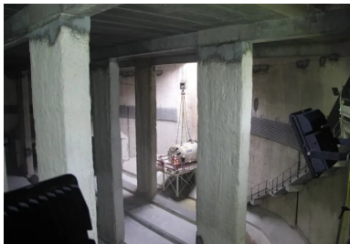
Sortie du micro-tunnelier dans le bassin
