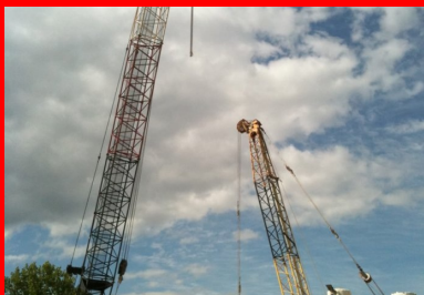
Installations de chantier
