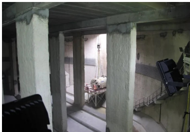
Sortie du micro-tunnelier dans le bassin
