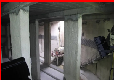
Sortie du micro-tunnelier dans le bassin
