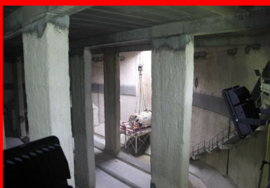
Sortie du micro-tunnelier dans le bassin
