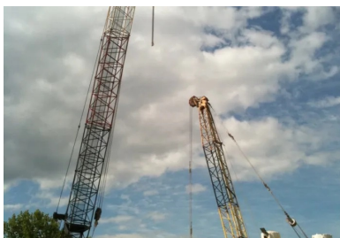
Installations de chantier
