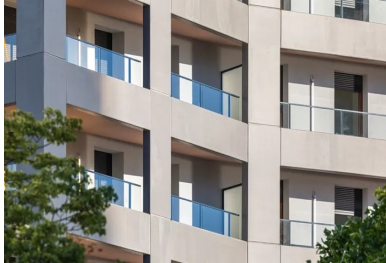
Des panneaux préfabriqués en béton dessinent la trame structurelle de la première peau qui abrite balcons et loggias.
