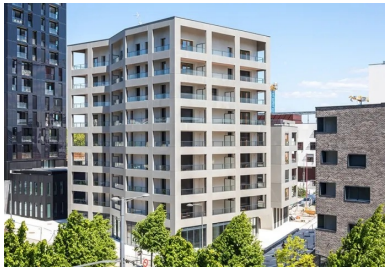
La forme plissée et dynamique de la façade sur la rue Edmond Michelet vient redonner un alignement en reliant les deux bâtiments voisins décalés l'un par rapport à l'autre, tandis que le volume installe une hauteur intermédiaire entre eux.
