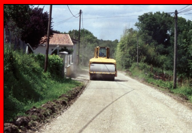
Compactage au rouleau vibrant.
