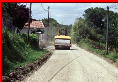
Compactage au rouleau vibrant.
