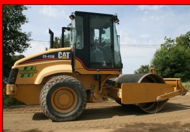
Compactage au rouleau vibrant.
