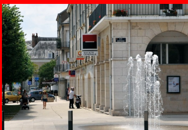
Blois, quai de la Saussayé, sur la rive droite. La rénovation des trottoirs en béton bouchardé s'est accompagnée de travaux d'embellissement. Ici, une fontaine.
