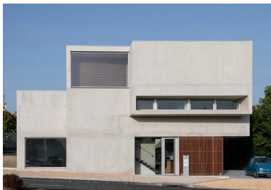
Les décalages, les mises en suspension, le rythme des opacités et des transparences sculptent ce bâtiment, dont la matérialité brute et l'élégance s'inscrivent avec force et pertinence dans le quartier.
