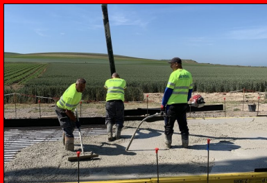
Bétonnage : alimentation du béton à la pompe, réglage au râteau, suivi du serrage du béton à l'aiguille vibrante.
