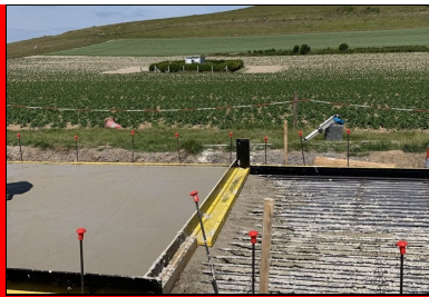
Pose d'un joint d'arrêt de bétonnage provisoire en fin de journée.
