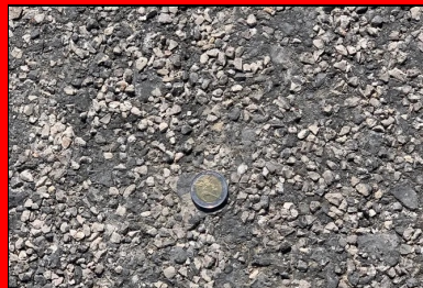
Aspect fini de la plate-forme support.
