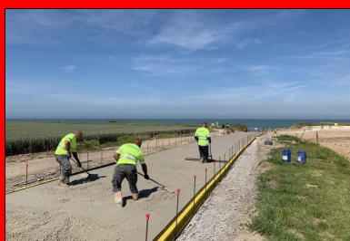
L'étalage du béton s'effectue à l'aide de différents outils : râteau, épandeur ou lissarde.
