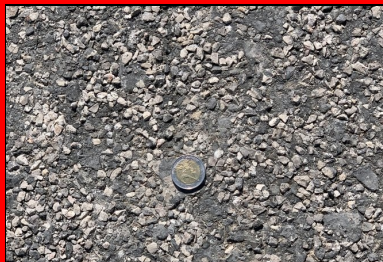
Aspect fini de la plate-forme support.
