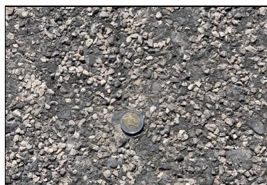
Aspect fini de la plate-forme support.
