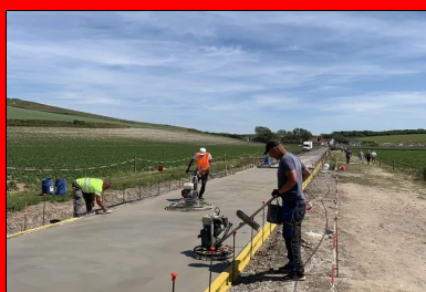
Deux lisseuses mécanisées (hélicoptères) achèvent le lissage fin.
