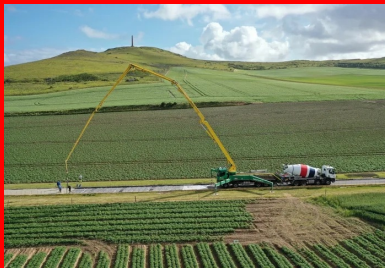
Coulage du béton sur la rue de la Mer avec vue sur le cap Blanc-Nez et l'obélisque à la mémoire de la Dover Patrol. Le débattement de la pompe limite le coulage à des sections de 60 mètres par jour (environ 270 m 3 , soit la capacité de six ou sept touppes).
