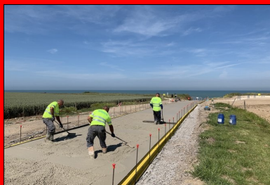
L'étalage du béton s'effectue à l'aide de différents outils : râteau, épandeur ou lissage.
