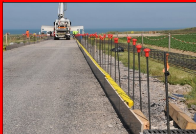
Préparation de la plate-forme support : purge, reprofilage, travaux d'assainissement, compactage et enduit superficiel.
