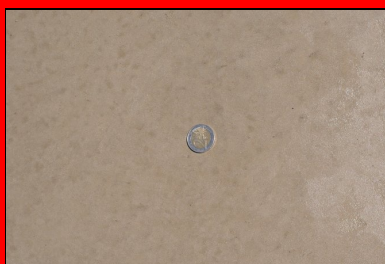
Aspect du BAC après lissage à l'hélicoptère.
