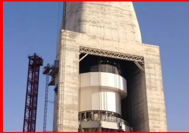
Cinq jours complets ont été nécessaires pour hisser le four solaire au sommet de la tour.
