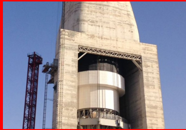
Cinq jours complets ont été nécessaires pour hisser le four solaire au sommet de la tour.
