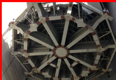
Le four solaire commence son ascension, hissé par vingt vérins avaleurs de câbles.
