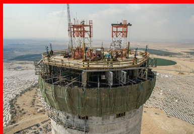
Le fût en béton armé de la tour, qui s'élève à 209 m de hauteur, est conçu pour soutenir le four solaire en son sommet.
