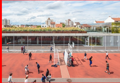
La dalle de toiture en béton du gymnase, soulevée au-dessus du sol, accueille un jardin.
