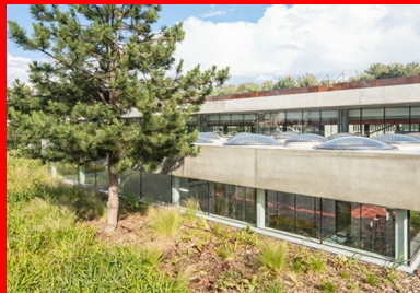
Sur la rue de Bellevue, le gymnase participe pleinement à l'aménagement paysager et semble posé sur un tapis végétal offert à la vue des riverains et des passants.
