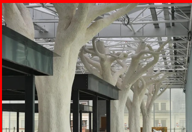
À 10 m du sol, la couverture de la mezzanine est portée par une allée d'arbres en béton projeté.
