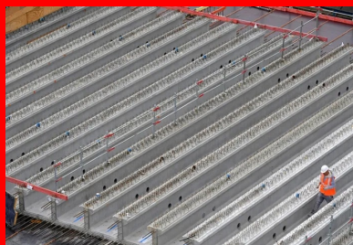
Le tablier est constitué de poutres préfabriquées en béton en forme de T inversé.
