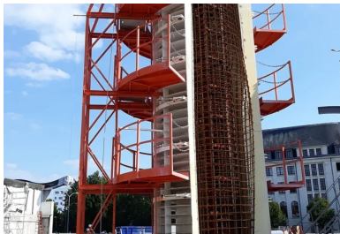
Les piles en béton blanc autoplaçant coulé en place portent la mezzanine.
