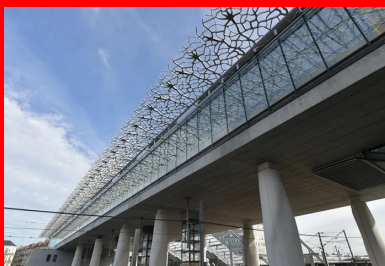
Les baies vitrées sont protégées des apports solaires par des ombrières en BFUP.
