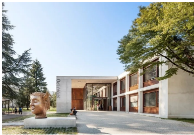
Au nord, la nouvelle entrée, facilement repérable et à l'échelle de la dimension internationale de l'IEP.
