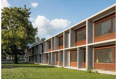
Grâce à une réhabilitation soignée, les façades datant des années 1960 semblent neuves et inchangées.
