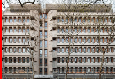
Façade principale rue de la Mouzaïa avec ses « dents de mammouth » en béton qui marquent les niveaux et ses « serre-livres ».
