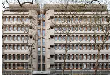
Façade principale rue de la Mouzaïa avec ses « dents de mammoth » en béton qui marquent les niveaux et ses « serre-livres ».
