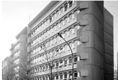
1974. Le bâtiment peu après sa livraison initiale.
