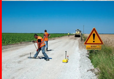
Contrôle de la compacité et de la teneur en eau de la chaussée à l'aide d'un gammadensimètre.
