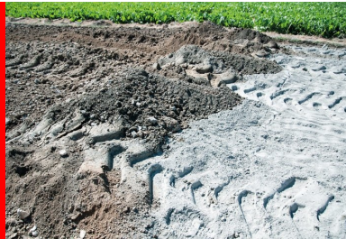
Résultat à l'issue du malaxage : le liant clair a été finement mélangé avec le matériau de l'ancienne chaussée.
