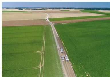
Vue aérienne du chantier de retraitement à froid au liant hydraulique routier de la RD36a, réalisé par la société Routes et chantiers modernes (RCM), avec du Rolac Optimum de Saint-Pierre-la-Cour de LafargeHolcim.
