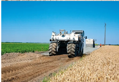
Le malaxeur Wirtgen 2400 intervenant sur une épaisseur de 45 cm de profondeur.
