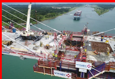
Le bétonnage de la zone de clivage permet de solidariser les deux fileaux du pont à haubans.
