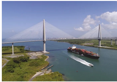
Avec une travée centrale de 530 m, le pont de l'Atlantique détient le record du monde de longueur pour un ouvrage haubané en béton.
