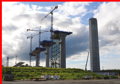
Les voussoirs du tablier des viaducs d'accès côté canal ont été construits en béton coulé en place par encorbellements successifs.
