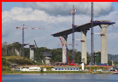
Pour éviter de multiplier les transports par barges à travers le canal, la quasi-totalité des éléments structurels sont coulés en place.
