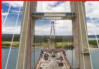
Pendant les travaux, afin d'éviter que les efforts soient trop importants en pied de pylônes, des balons provisoires étaient installés entre les deux jambes.
