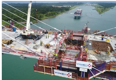
Le bétonnage de la zone de clavage permet de solidariser les deux fléaux du pont à haubans.
