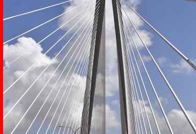
Ancrés sur les pylônes de 212,5 m de haut, les 256 haubans sont répartis en 2 nappes latérales inclinées.
