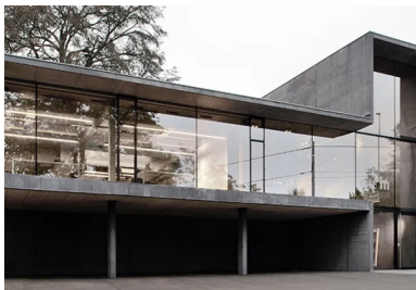
Vue de la façade sur rue.
