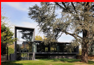
Vue de la façade sud ouverte sur le jardin dominé par un majestueux cèdre du Liban.
