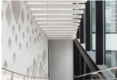
Les marches ancrées dans le mur d'échiffre peuvent présenter un porte-à-faux allant de 1,40 m à 1,68 m.
