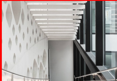
Les marches ancrées dans le mur d'échiffre peuvent présenter un porte-à-faux allant de 1,40 m à 1,68 m.
