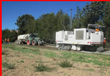
L'un des vingt-six chemins ruraux en cours de réfection. Au total, environ 30 km de voirie ont été rénovés dans les secteurs Puyricard-Couteron-Céron-La Galade-jas de Bouffan-Les Milles et Luynes.
