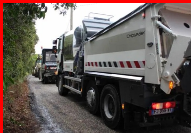
Difficulté : l'étroitesse des voies (< 3,50 m).
