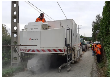
La chaussée est décohésionnée et malaxée.
