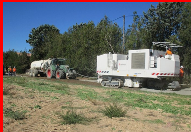
L'un des vingt-six chemins ruraux en cours de réfection. Au total, environ 30 km de voirie ont été rénovés dans les secteurs Puyricard-Coutèron-Céron-La Galade-jas de Bouffan-Les Milles et Luynes.
