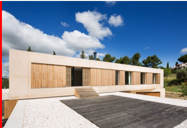
Les chambres et l'espace commun des filles profitent d'une terrasse en toiture de l'aile basse.
