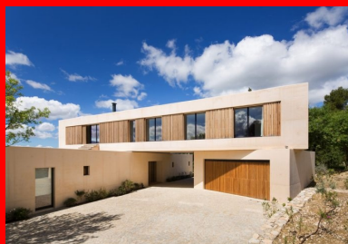
L'étage des filles, en équilibre sur le porche d'accès vers la maison. En bas à droite, le garage.
