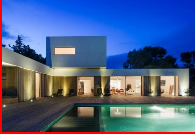
De nuit, l'intérieur de la maison se révèle comme une boîte à lumière.
