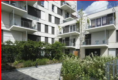
La totalité des logements bénéficient d'un prolongement extérieur privatif dont la superficie moyenne est de 10 m 2 par logement.
