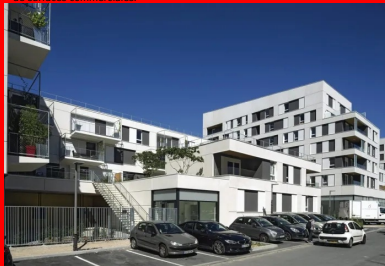
Le programme général de l'opération est marqué par sa mixité, avec 89 logements collectifs, 40 logements sociaux, mais aussi 7 petites maisons de ville. L'ensemble dessine un épannelage descendant vers le sud.
