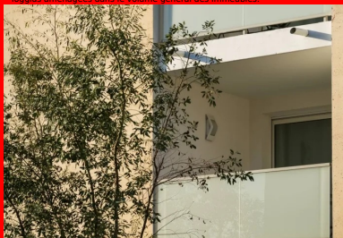
Les façades en béton sont coulées en place dans des matrices de type « travertin ».
