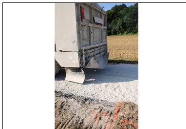
Épandage du liant
