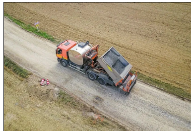
Mise en œuvre de l'enduit de protection
