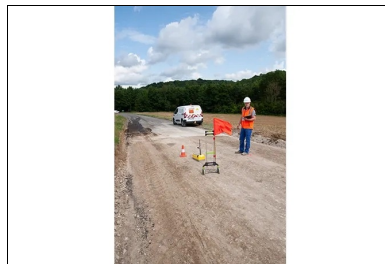
Contrôle de compactage au gamma-densimètre
