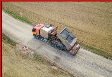
Mise en œuvre de l'enduit de protection
