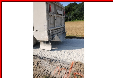
Épandage du liant
