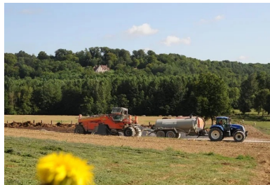
Technique éprouvée, le retraitement en place au LHR combine intégration écologique et respect du site, en évitant notamment l'extraction et la mise en décharge des matériaux pollués par une noria de camions
