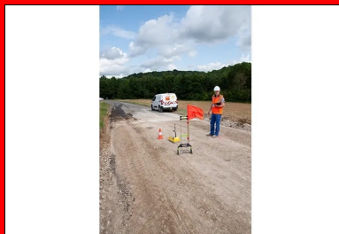
Contrôle de compactage au gamma-densimètre
