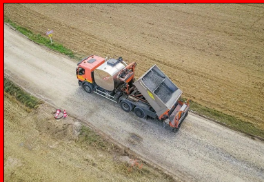
Mise en œuvre de l'enduit de protection
