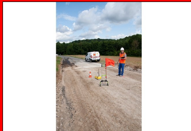
Contrôle de compactage au gamma-densimètre
