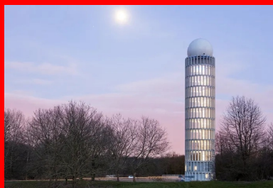
À l'arrière du volume principal habillé de panneaux de façade en BFUP projeté, émerge le volume de la halle technique.
