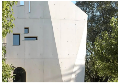
Vues de la façade sud
