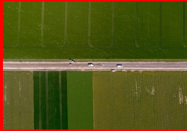
L'ARC 1000 assure le malaxage du liant avec le fraiseur d'enrobés et les matériaux de l'ancienne chaussée sur une profondeur de 25 cm (dans l'axe de la chaussée) et de 30 cm en rive. L'ajustement de la teneur en eau est apporté par injection directe dans la cloche de l'ARC 1000 grâce à une citerne d'eau.
