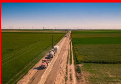
L'atelier de retraitement en action. Les bandes d'élargissement sont visibles de part et d'autre de la chaussée.
