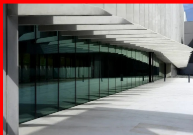
Les cils/brise-soleil verticaux cadrent les vues depuis l'intérieur, protègent du rayonnement solaire direct et offrent des vues changeantes des façades.
