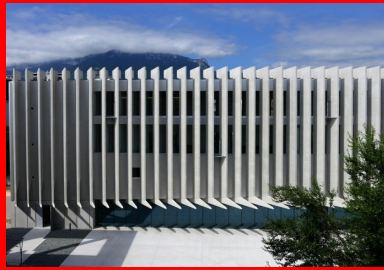
Les cils/brise-soleil verticaux cadrent les vues depuis l'intérieur, protègent du rayonnement solaire direct et offrent des vues changeantes des façades.
