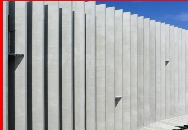
Côté cour, les éléments préfabriqués horizontaux composent la marquise qui invite à entrer dans le hall d'accueil.
