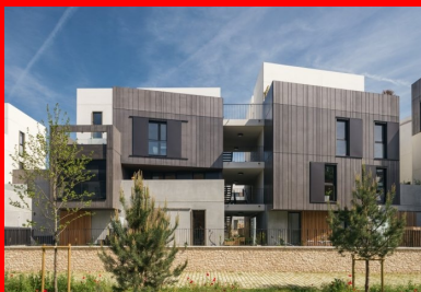
Les sous-bassements sont en béton brut, les parties en débord sont striées et teintées dans la masse, et les acrotères en béton blanc.
