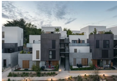
Les escaliers, situés à l'extérieur, créent des failles de circulation.
