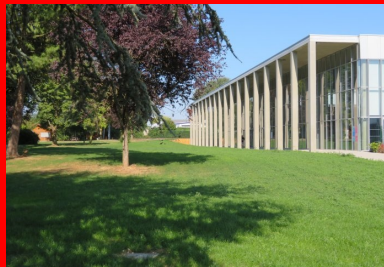
Colonnade de béton de la galerie-aveut dont les poteaux de section carrée ont les angles coupés.
