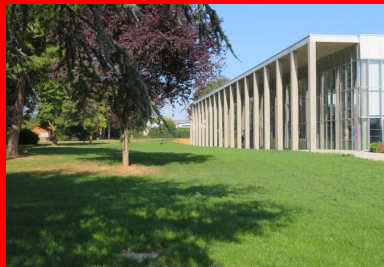
Colonnade de béton de la galerie-auvent dont les poteaux de section carrée ont les angles coupés.
