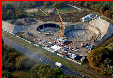
Les travaux de terrassement à l'intérieur des cylindres ont pu être menés une fois l'enceinte étanche achevée.
