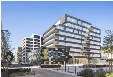
Les trois bâtiments du site dessinent un petit pôle urbain.
