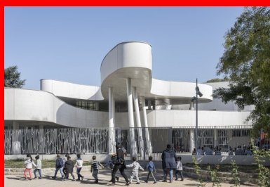
Les superpositions de niveaux engendrent une densité constructive.
