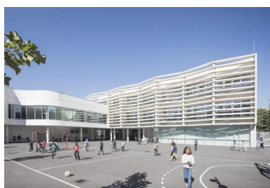
Les brise-soleil en béton blanc animent la façade sud.
