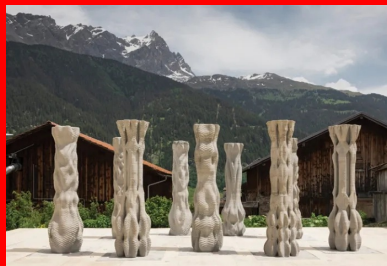
Colonnes imprimées en béton 3D - ETH Zurich
