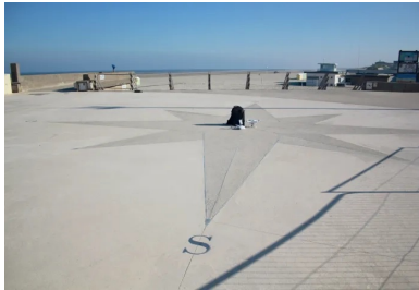
La magnifique rose des vents dont les branches forment des angles aigus, ce qui rend délicate la mise en œuvre du béton a été réalisée avec un soin tout particulier.
