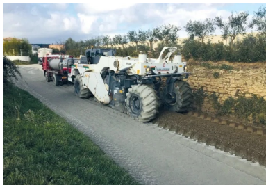
L'atelier de traitement d'Eurovia intervient sur une épaisseur de 32 cm et sur une largeur de 2,50 m par passage
