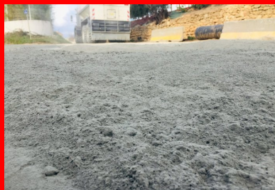
Le liant hydraulique routier après épandage : 190 tonnes de LV-TS 13 de Vicat ont été mises en œuvre à raison de 40 kg/m 2 .
