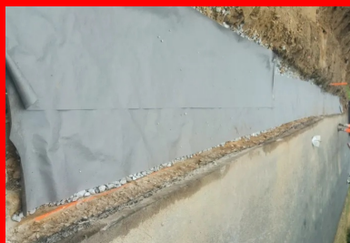
Une base drainante de 20 cm a été constituée en fond de fouille. Elle a été réalisée en matériaux drainants de granulométrie 20/40 et placés dans un géotextile anticontaminant (chaussette). Elle a facilité l'essorage du Macés.
