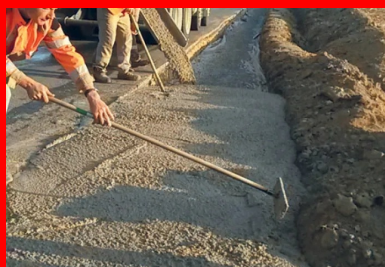
Les premières poutres Macés (40 cm d'épaisseur) ont été réalisées à compter de début septembre 2018. La mise en œuvre s'est effectuée par simple versement dans la fouille depuis les toupies, suivi d'un traitement manuel léger et d'une finition au râteau.
