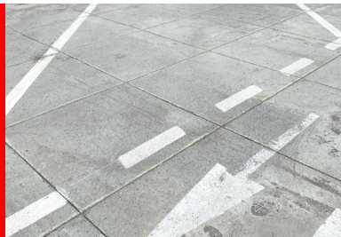
Le calepinage des sciages a été réalisé selon un quadrillage de 1,20 x 1,20 m. Total : 2 100 mètres linéaires.
