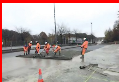
L'ancien enrobé orniéré a été raboté sur une épaisseur de 10 cm. Durée d'intervention pour respecter le planning : une journée.
