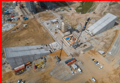
Les deux carnaux évacuent les gaz de propulsion émis lors du décollage.
