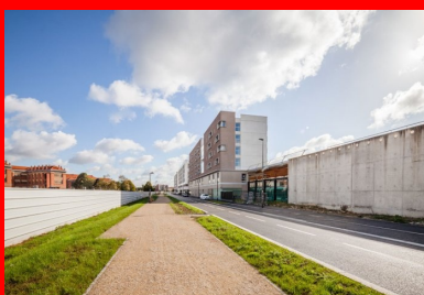
Sur la rue de la pépinière, les trois immeubles composent une amorce de front urbain. Au premier plan à droite, vue d'une équerre en béton sur laquelle sera partiellement construit un futur bâtiment.
